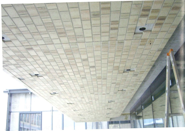
Die Deckenplatten sind montiert. Die noch offenen Aussparungen für die Montageanker werden mit Klinker-Riemchen verschlossen
