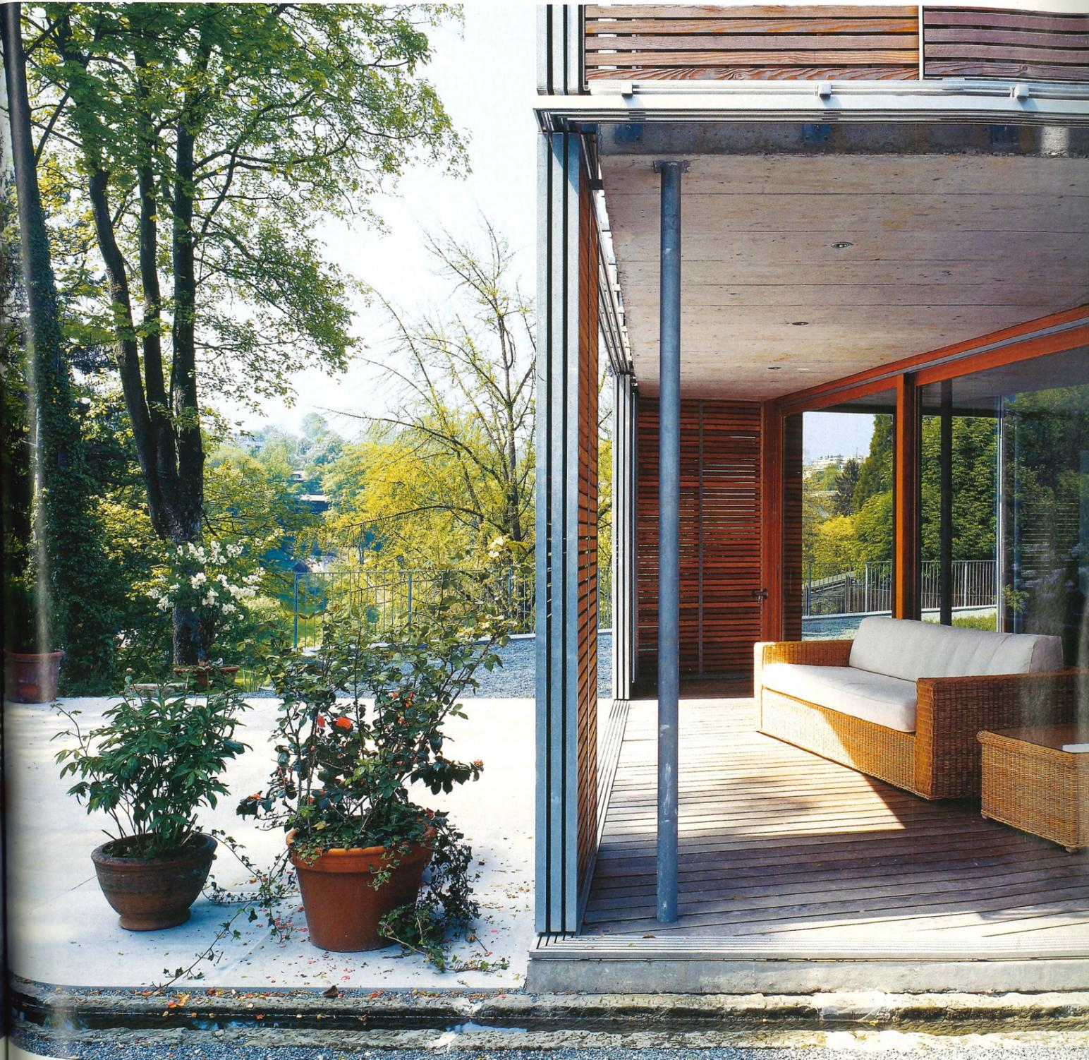
Neuinterpretation der klassischen Veranda. Aussen- und Innenräume fließen ineinander. Schön erkennbar ist die Baukonstruktion mit Betonplatten und Stahlstützen.
