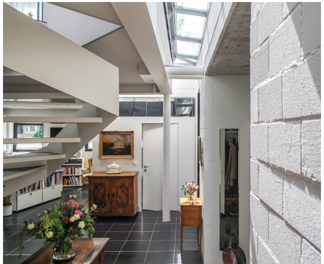
Der Eingangsbereich zum grossen Wohnraum im EG. Rechts das im Innern weiss gestrichene Kalksandsteinmauerwerk, links die Metallwendeltreppe, oben das umlaufende Lichtband.
